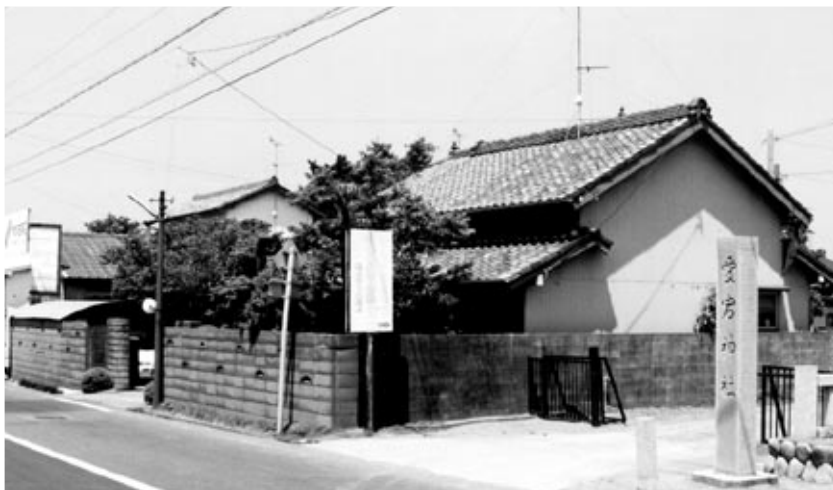
昭和21年3月、ミシン中釜の製造で軌道にのった当社は小楠金属工業所としてスタートを切った。創業地の浜名郡篠原村坪井1番地には、現在は住宅が建つ。
