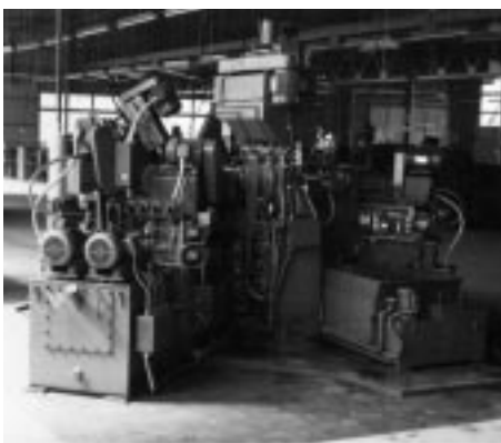
第一工場西側の増設途中で、その完成を待たずに設置したロータリーインデックスマシン（IT29）。
