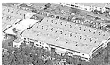
昭和52年設立の新利根小楠工業は「新利根農機部品工業団地」に参加。
