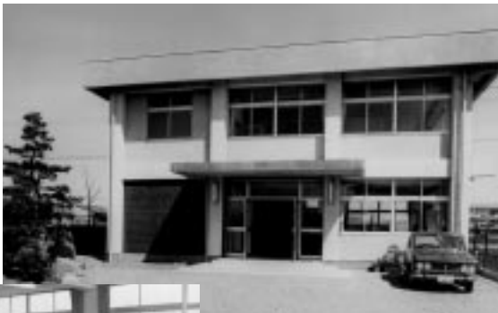
昭和42年、鉄筋2階建ての事務所を建設した。
